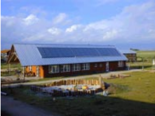
Solfanger til opvarmning af brugsvand
